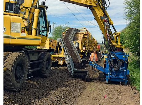
Die Kombination setzt sich aus zwei Komponenten zusammen: einer Grabenfräse und einem Übergabewagen, die für einen sofortigen Abtransport des Aushubmaterials durch Güterwagen (z.B. MFS) auf ein Zwischenlager sorgen.
